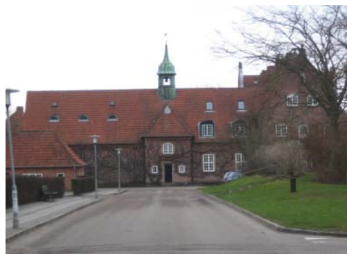
Administrationsbygningen mod Bakkegården - vestfløj
